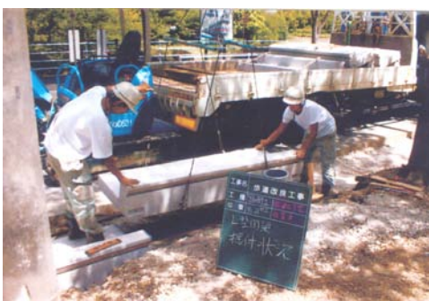
豊明市 歩道改良工事
